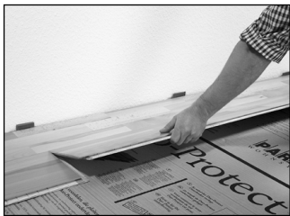
Další řadu začněte opět zleva. Palubky sečvakněte na podélné straně. Lepení palubek není třeba.
