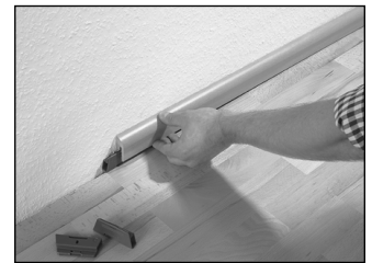
Okrajové spáry je možné zakrýt vhodnými podlahovými lištami ze sortimentu Parador.
